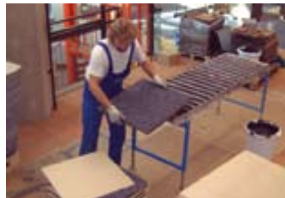
Die Platten werden abgestapelt.
