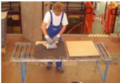
Der Spezialklebstoff wird aufgetragen.
